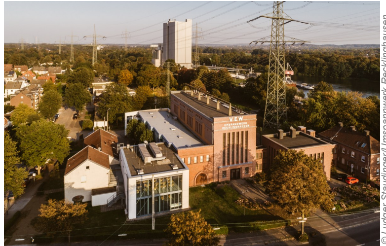
© Ludger Staudinger/Umspannwerk Recklinghausen
